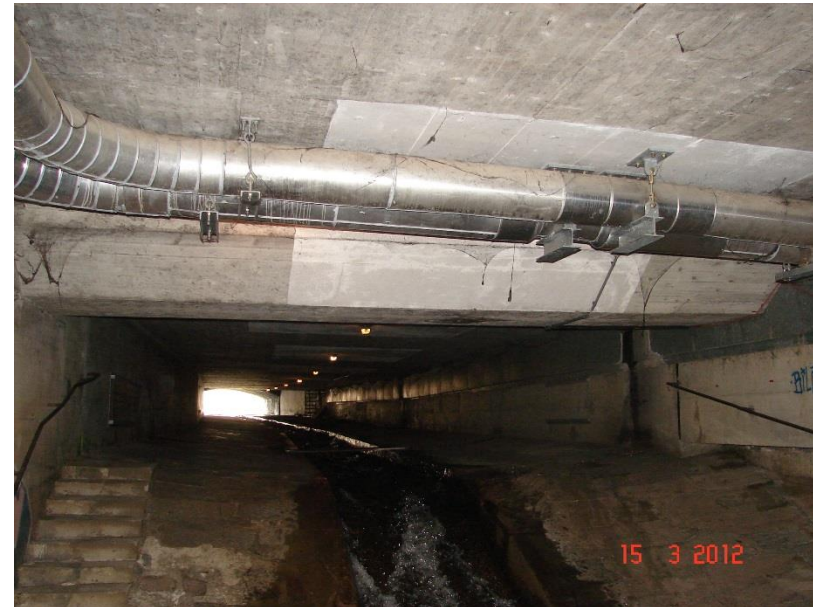
Abb: Unterzug im Tunnel (Quelle: TBA, Basel-Stadt)
