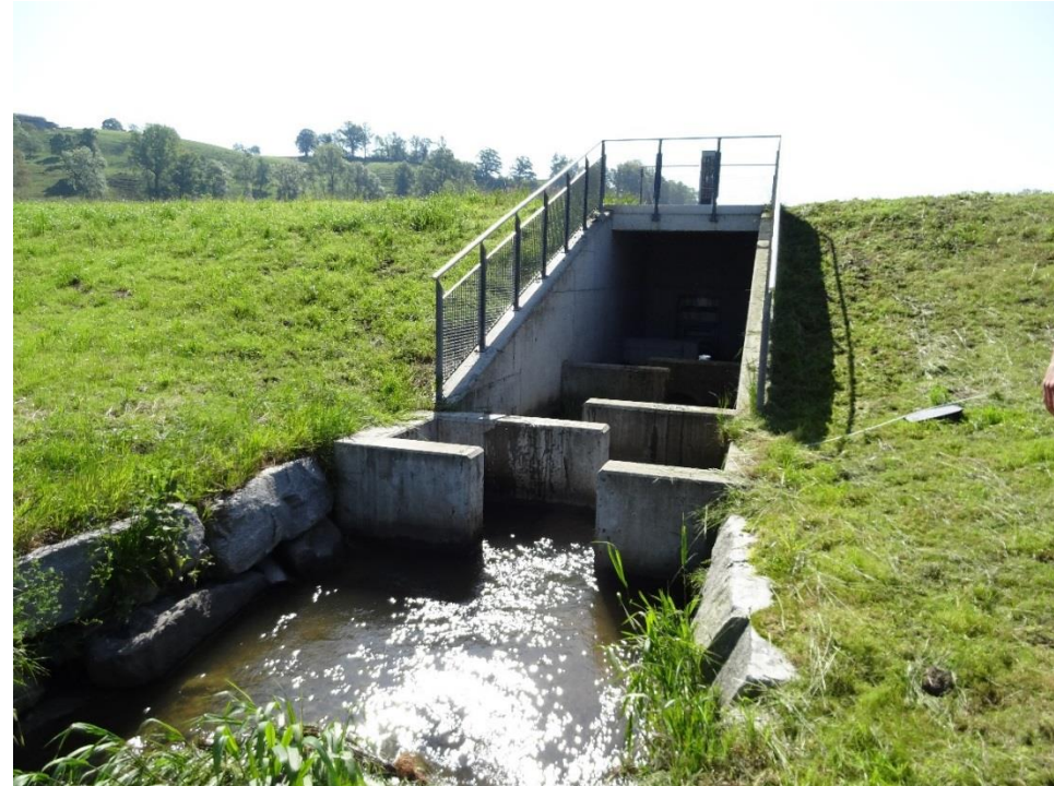
Abb: Unterwasser Ansicht des Tosbeckens des Rückhaltebeckens
